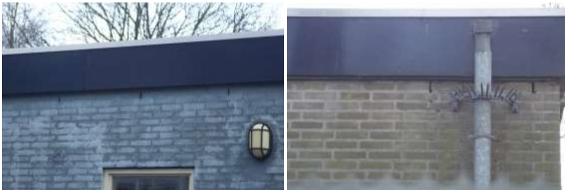
Open stootvoegen in de buitengevel bieden vleermuizen de kans een verblijfplaats te bezetten in de spouw.
